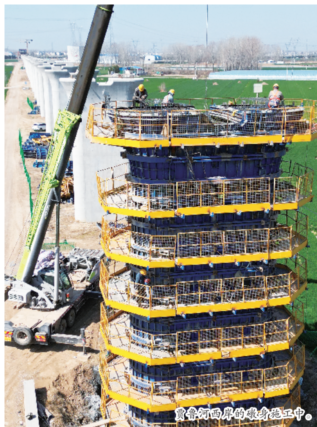
工人在扎“钢筋笼”，为浇筑做准备。
