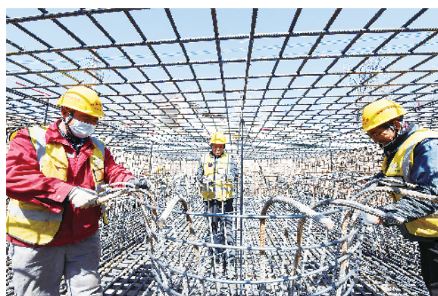
工人在扎“钢筋笼”，为浇筑做准备。
