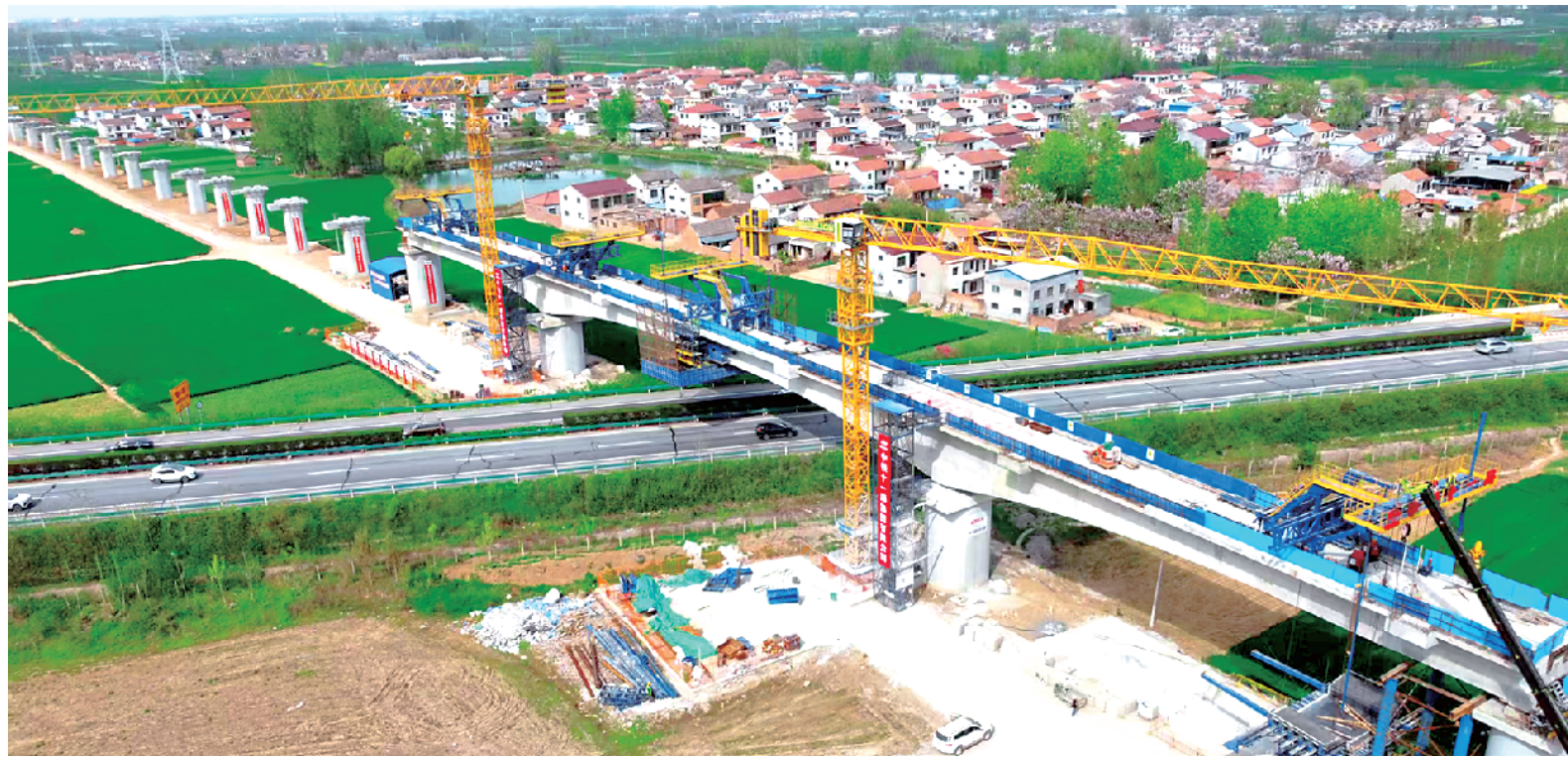
4月4日,周口中心港集疏运铁路专用线跨宁洛高速特大桥连续梁合龙。
